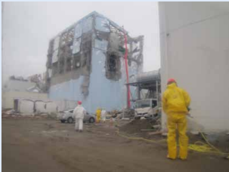
福島第1原発4号機原子炉建屋への注水作業 (3月22日撮影。東京電力ホームページより)
